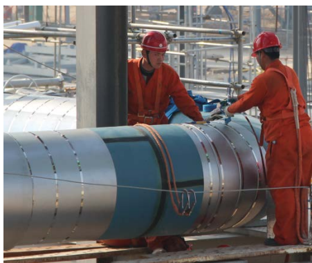
柔性系统无需防潮层，可在绝热层外直接安装金属外护层
