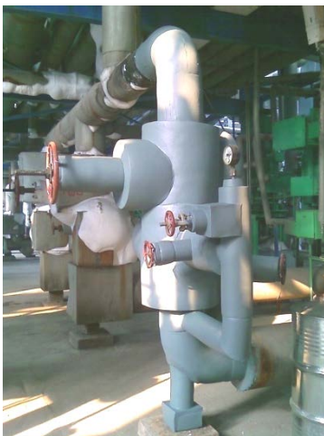
柔性系统可便捷的处理异形部件，并制成良好的水汽密闭系统。
